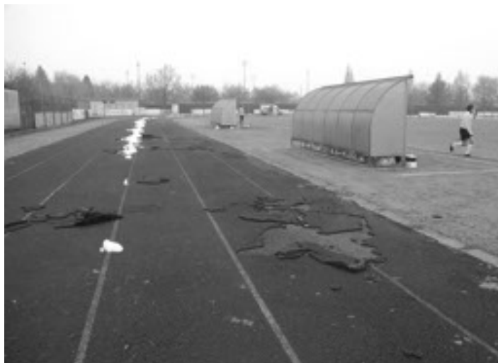
La pista si va sgretolando: neve e pioggia le hanno dato il colpo di grazia
